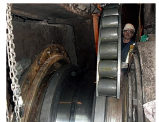
Travaux de montage d'un roulement à rotule sur rouleaux FAG sur le convertisseur
