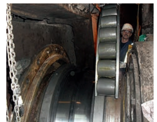
Montagearbeiten eines FAG-Pendelrollenlagers am Konverter
