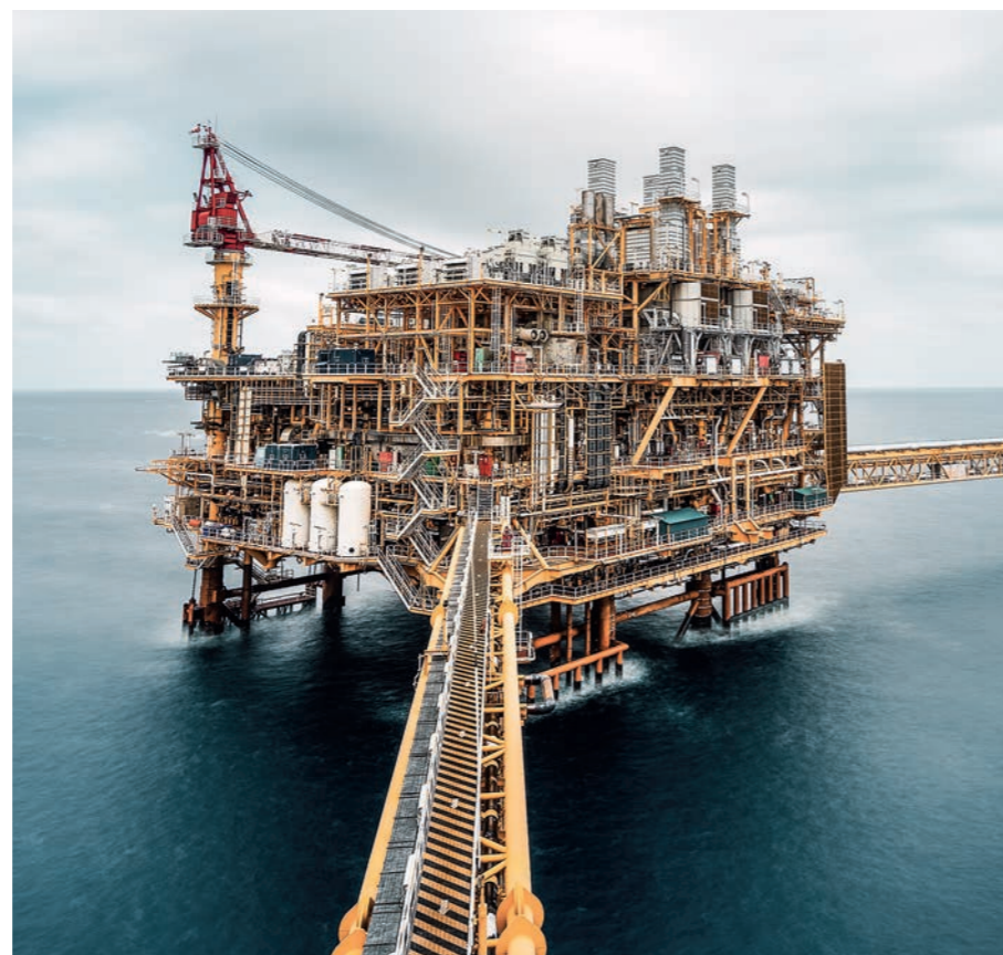
Plates-formes de forage
