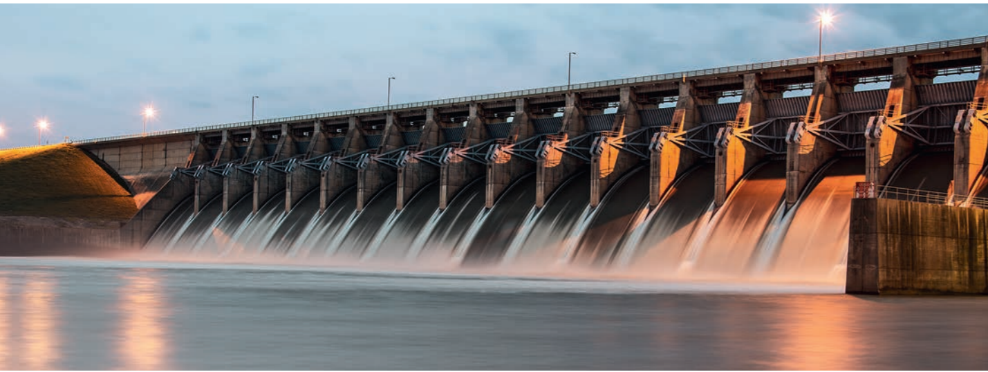
Barrage avec rotule lisse au niveau des portes de flot
