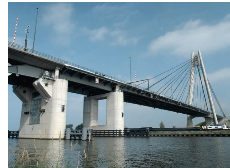
Klapp- und Hängebrücke
