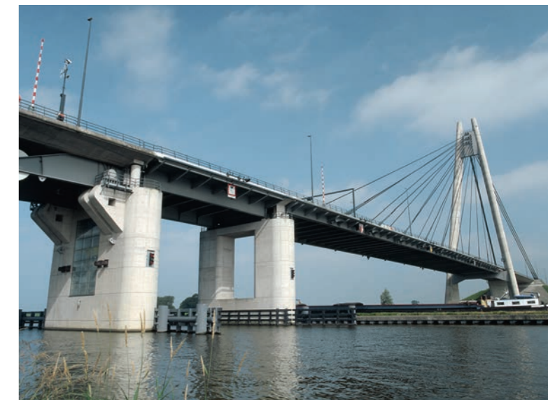
开合桥和吊桥
