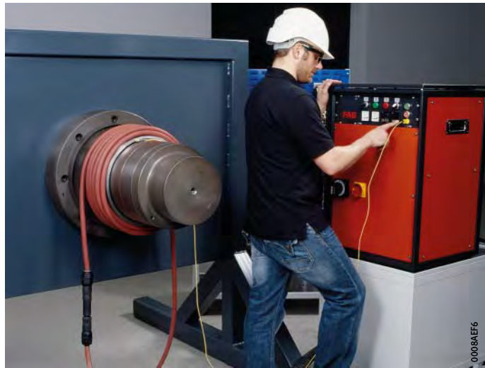
Figura 10 Desmontaje de anillos interiores mediante inductores flexibles
