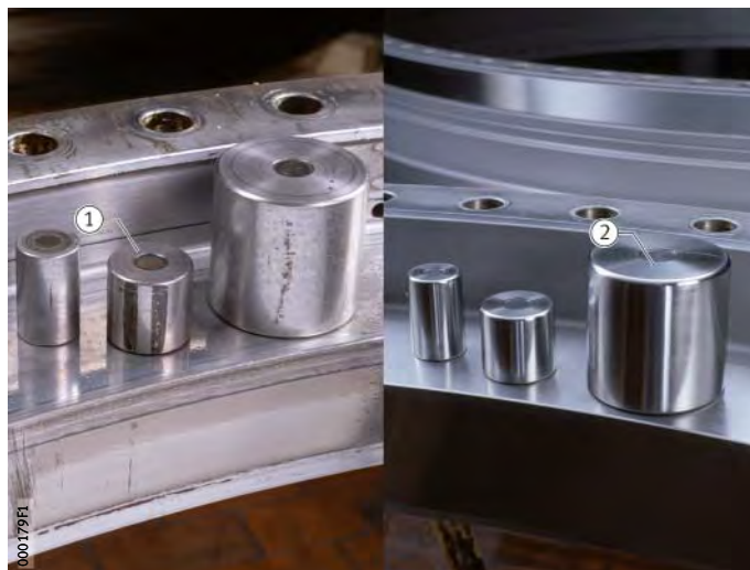
Figura 3 Las pistas de rodadura y los rodillos del rodamiento antes y después del reacondicionamiento
