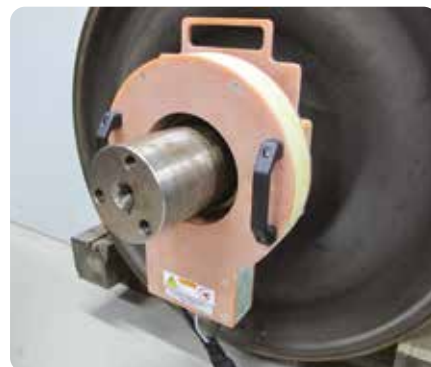
Nagrzewanie pierścieni labiryntowych do demontażu
