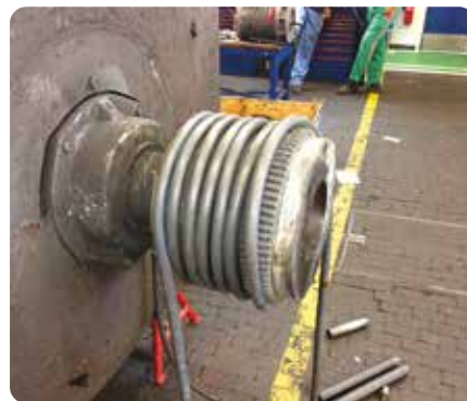
Verwarming van een koppeling voor demontage
